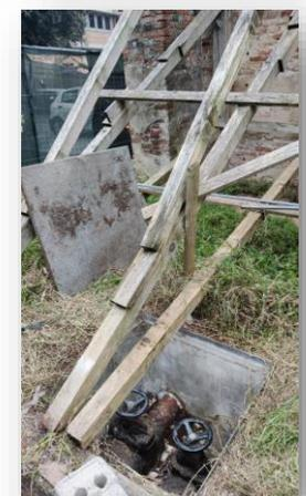
Al fine di procedere alla riparazione e operare in sicurezza, occorre provvedere alla modifica del percorso delle tubazioni intercettandole prima e dopo il manufatto puntellato.
