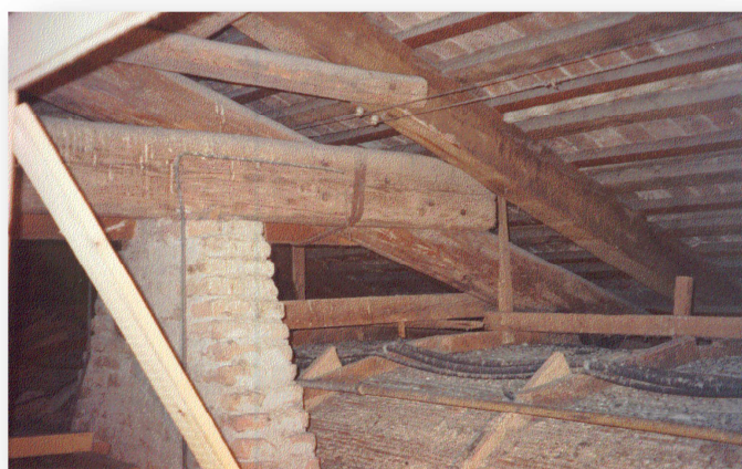
Figura 15. Sezione trasversale della copertura di un'ala di palazzo Strozzi, da cui si nota la parete di spina con un appoggio puntuale per le strutture lignee (immagine tratta dall'Elaborato RGT05 di [8]).
