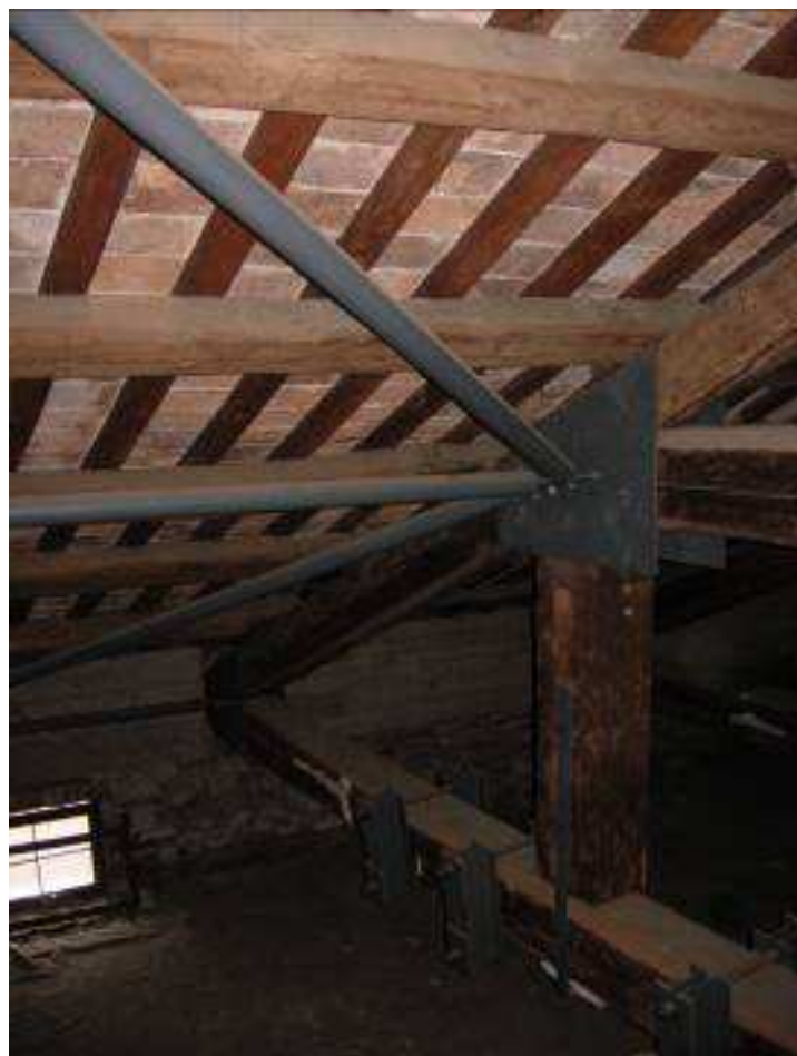
Figura 10. Controventi di falda metallici nella copertura di Palazzo Tassoni-Mirogli.
