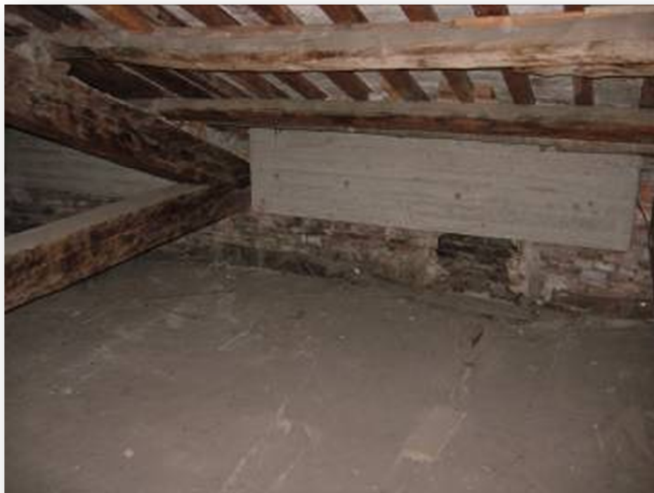
Figura 13. Contrappeso in c.a. alla quota di gronda di Palazzo Tassoni-Mirogli.
