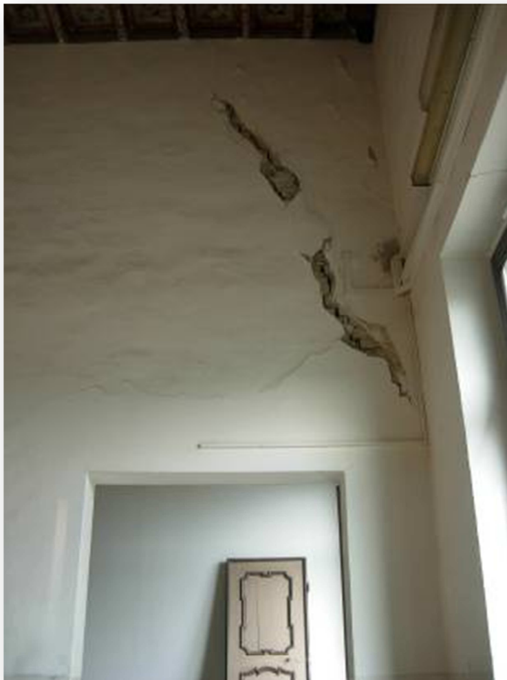
Figura 18. Palazzo Tassoni-Mirogli. Quadro fessurativo in una parete ortogonale ad una parete perimetrale, con parziale mobilitazione di un cuneo di distacco.
