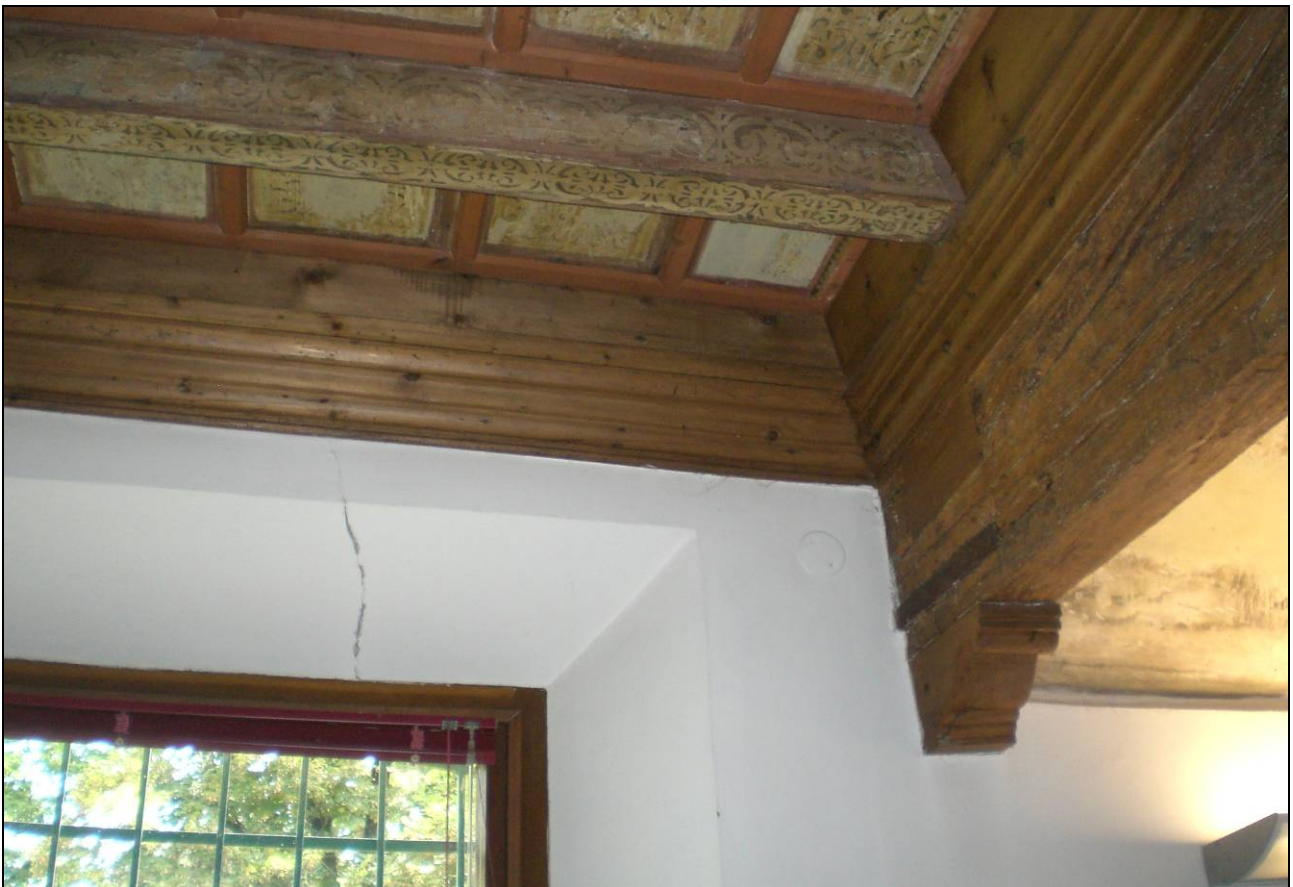
figura 5.6.2b - Foto n°.06 piano ammezzato
