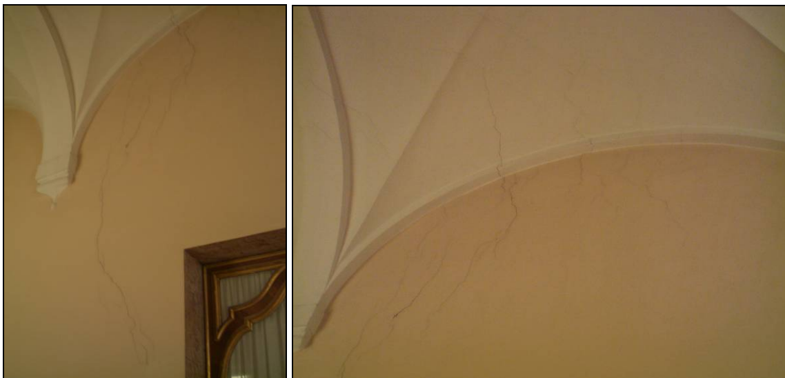
figura 5.6.4i - Foto n°.56, 57 - piano nobile (primo)
