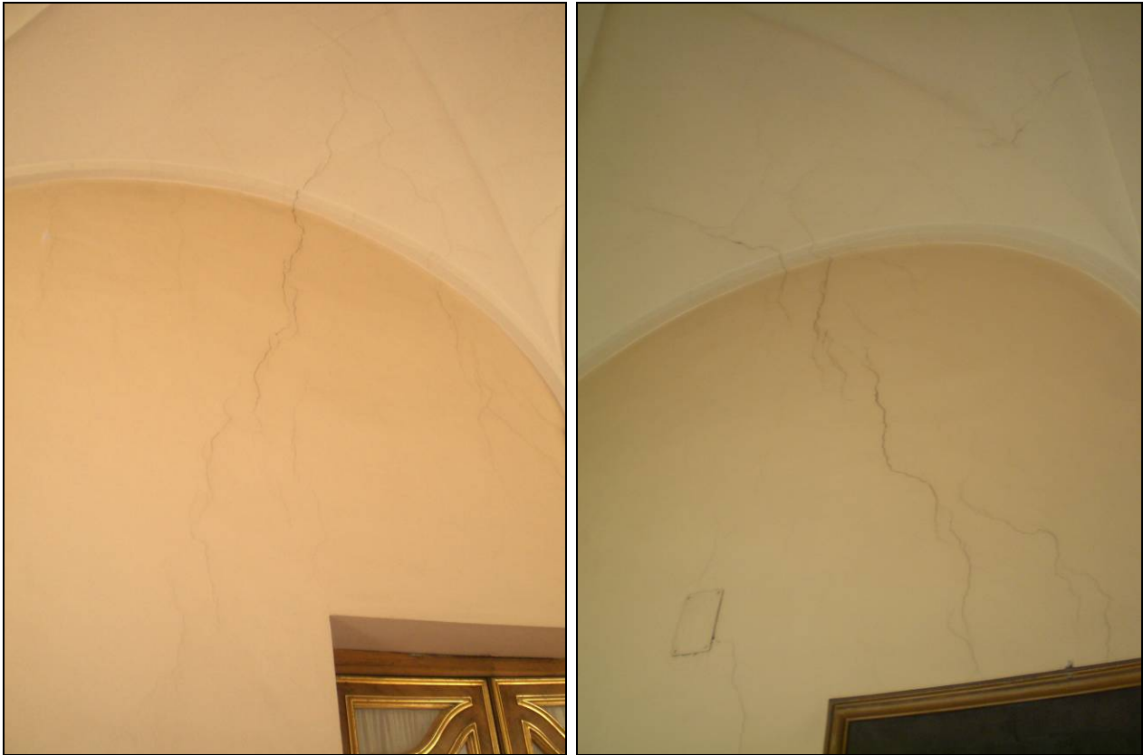
figura 5.6.4g - Foto n°.53, 55 - piano nobile (primo)
