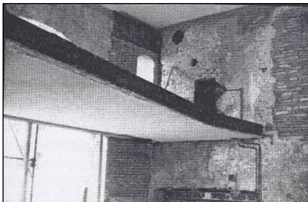
figura 3.4 - Realizzazione piani ammezzati
