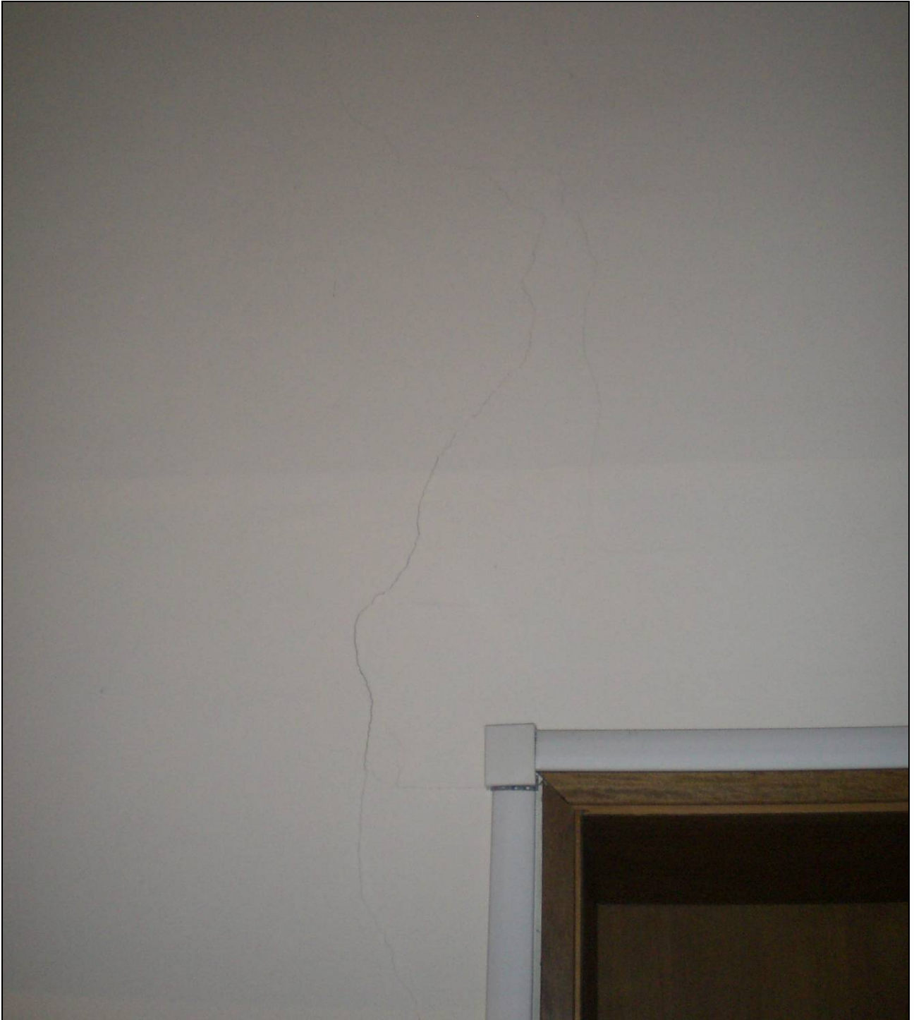
figura 5.6.1b - Foto n°.65 (piano terra)
