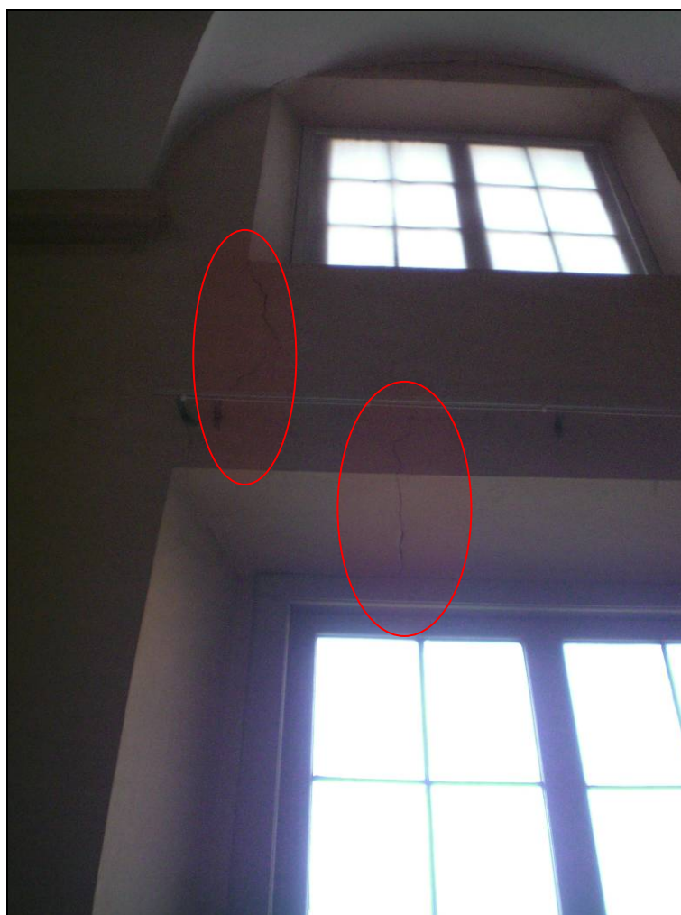
figura 5.6.4e- Foto n°. 16, 17 - piano nobile (primo)
