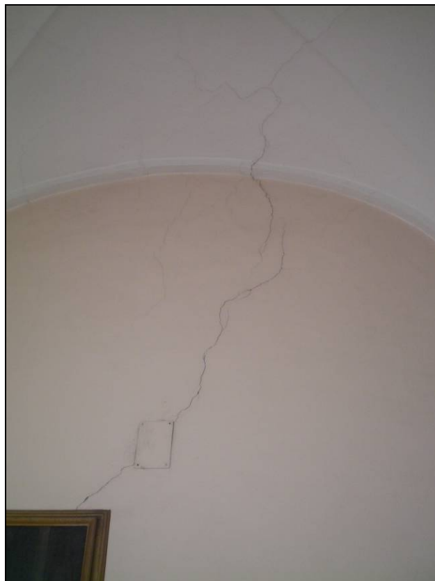
figura 5.6.4g - Foto n°.52 - piano nobile (primo)
