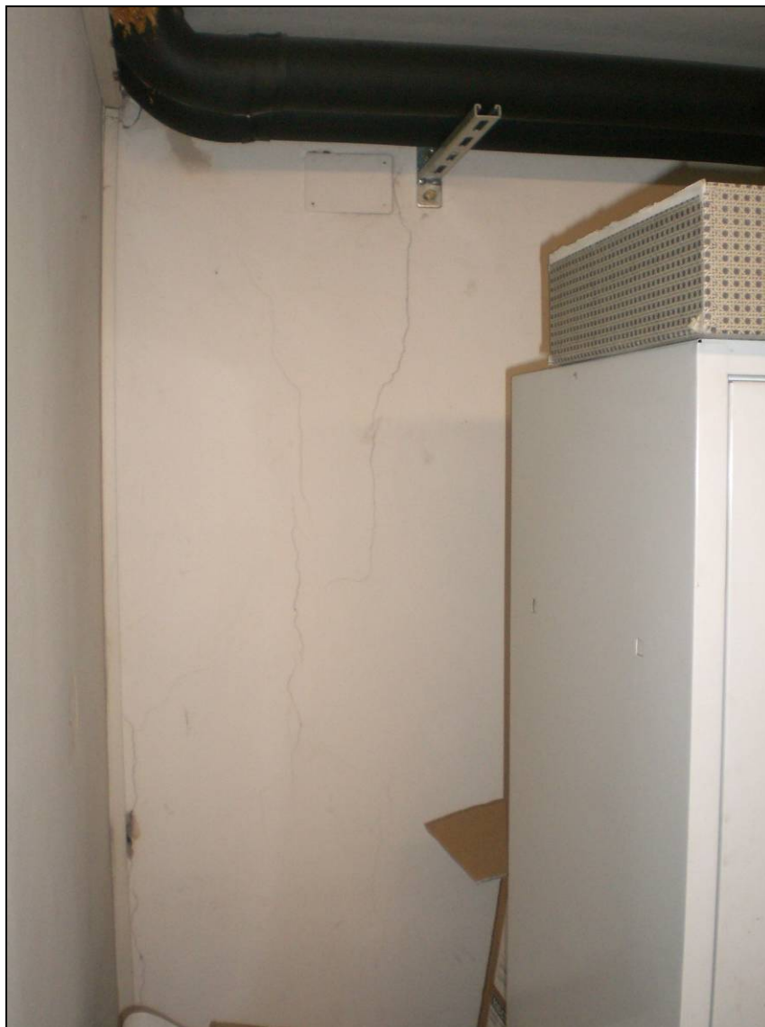
figura 5.6.3b - Foto n°.22 - murature piano ammezzato
