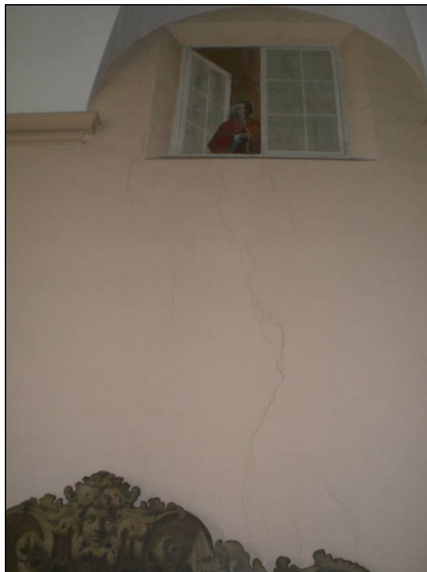
figura 5.6.4d - Foto n°.10 - piano nobile (primo)
