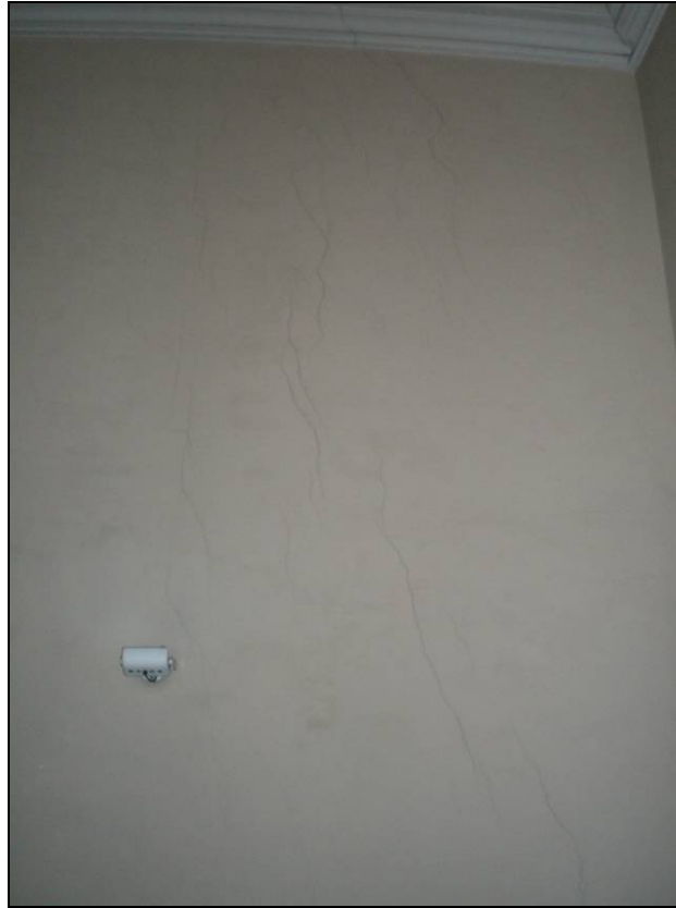
figura 5.6.4c - Foto n°.33 - piano nobile (primo)
