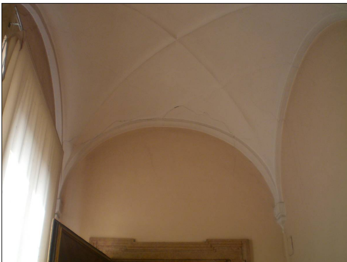
figura 5.6.4l - Foto n°.58 - piano nobile (primo)
