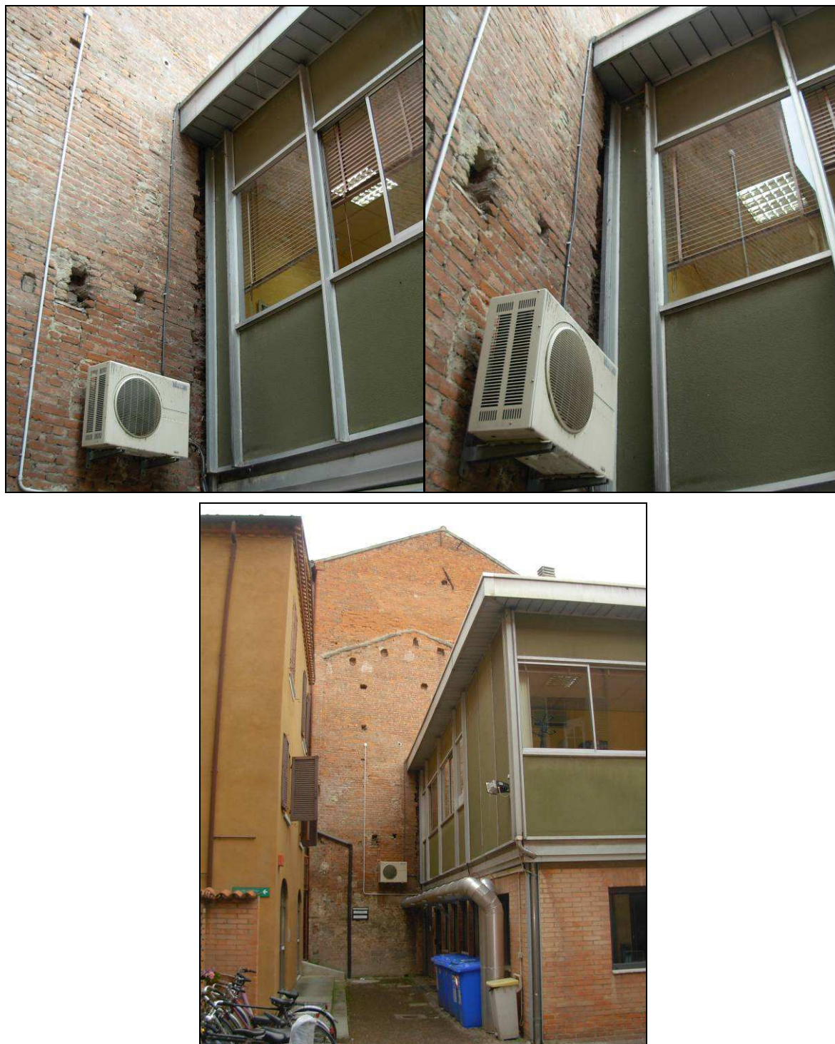
Figura 5.1.15 - Vista prospetto N-O Corpo Ovest Palazzo Strozzi dalla Corte secondaria di Renata di Francia
