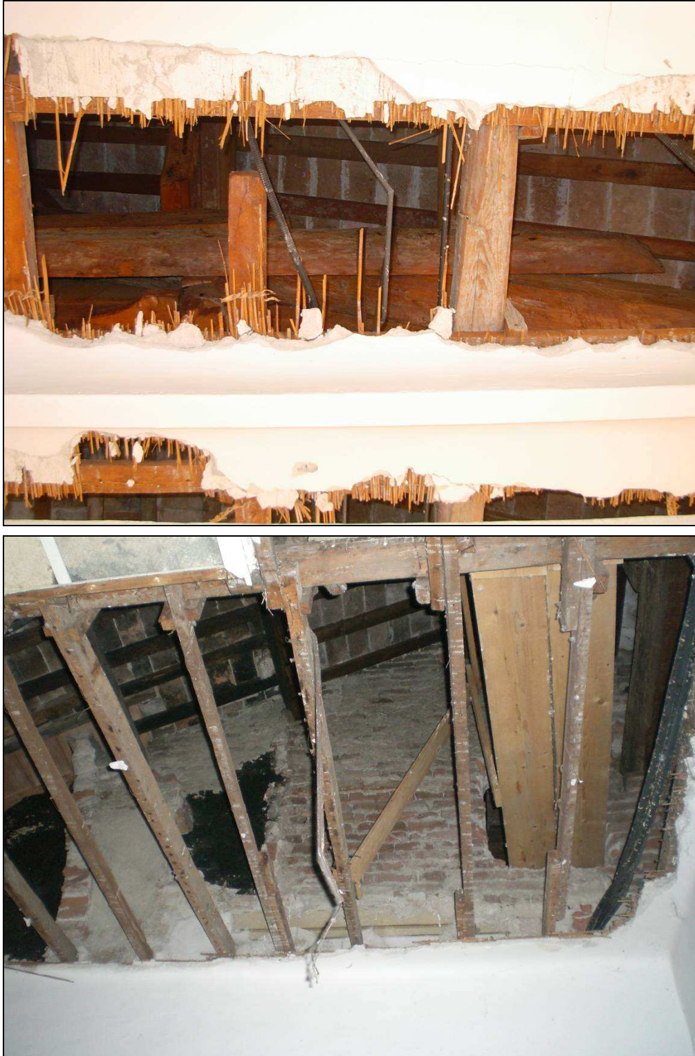
Figura 5.3.8 - Corpo originario dello Strozzi: strutture lignee di copertura (Foto n°26, 31)
