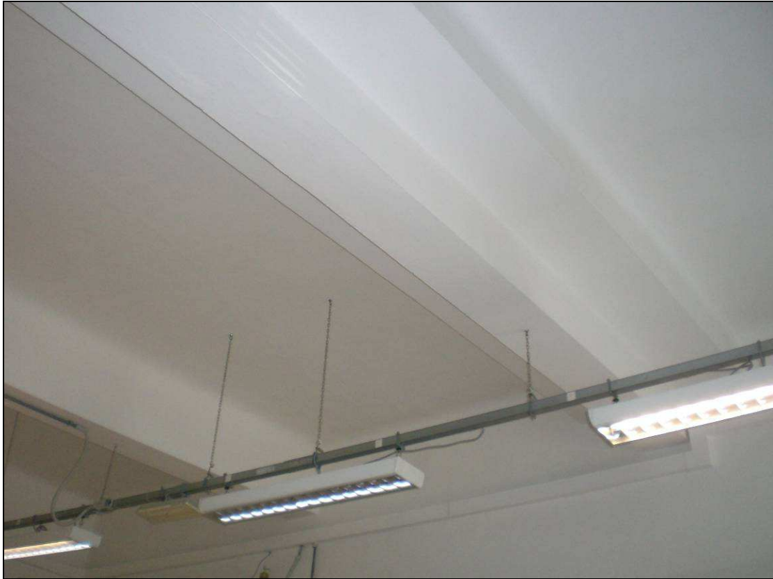
Figura 5.3.4a - Ex Palazzo Strozzi: solai lignei (rivestiti) - Foto n°96
