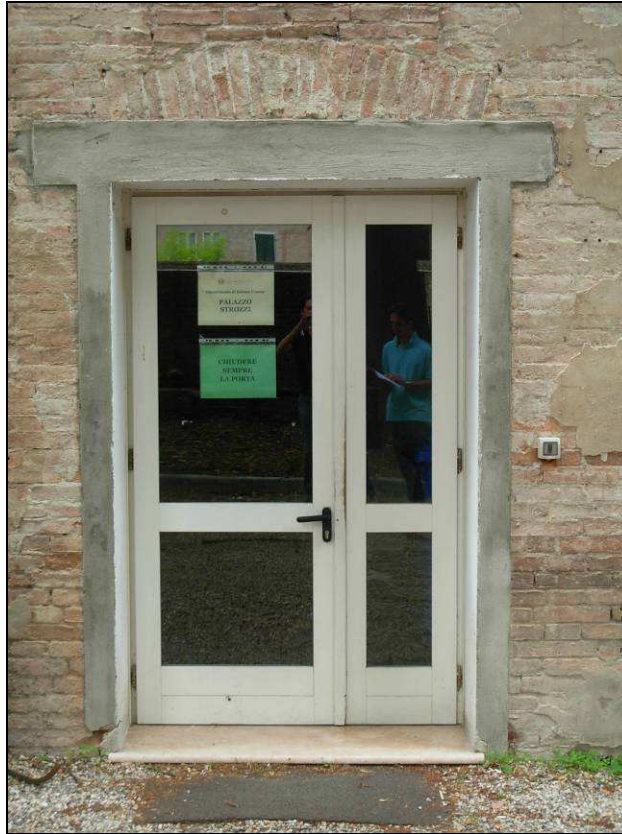
Figura 5.1.5 - Realizzazione apertura (Foto n°8 - P.T.)
