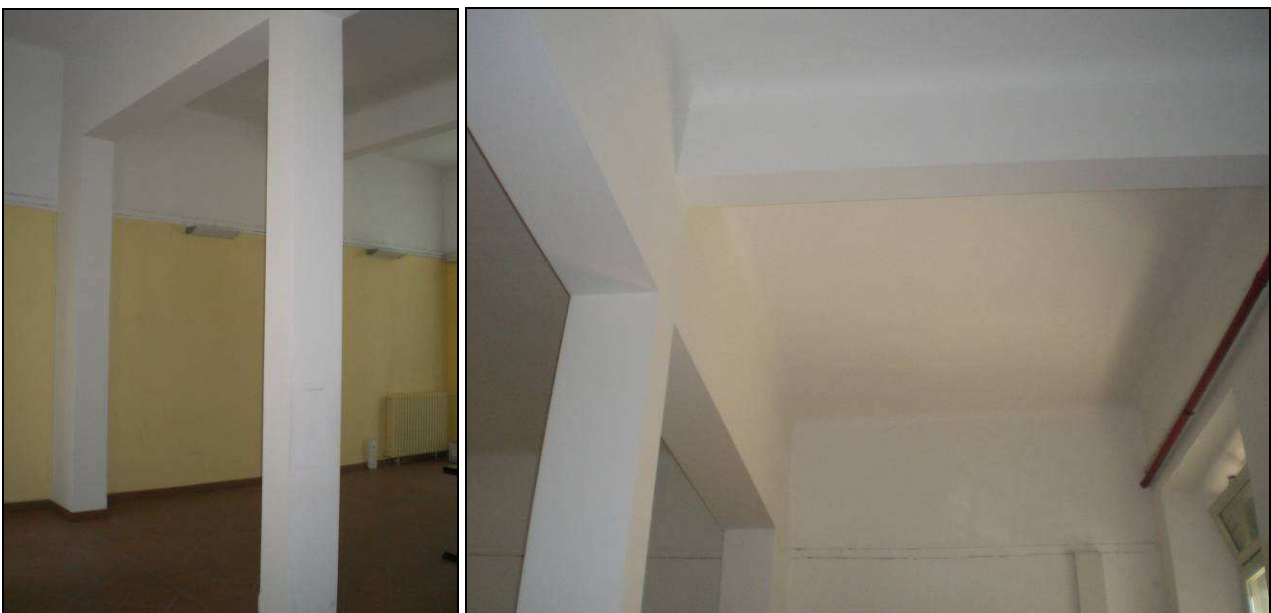
Figura 5.3.6 - Ex Casamento Savonarola: Telaio misto c.a. - acciaio
