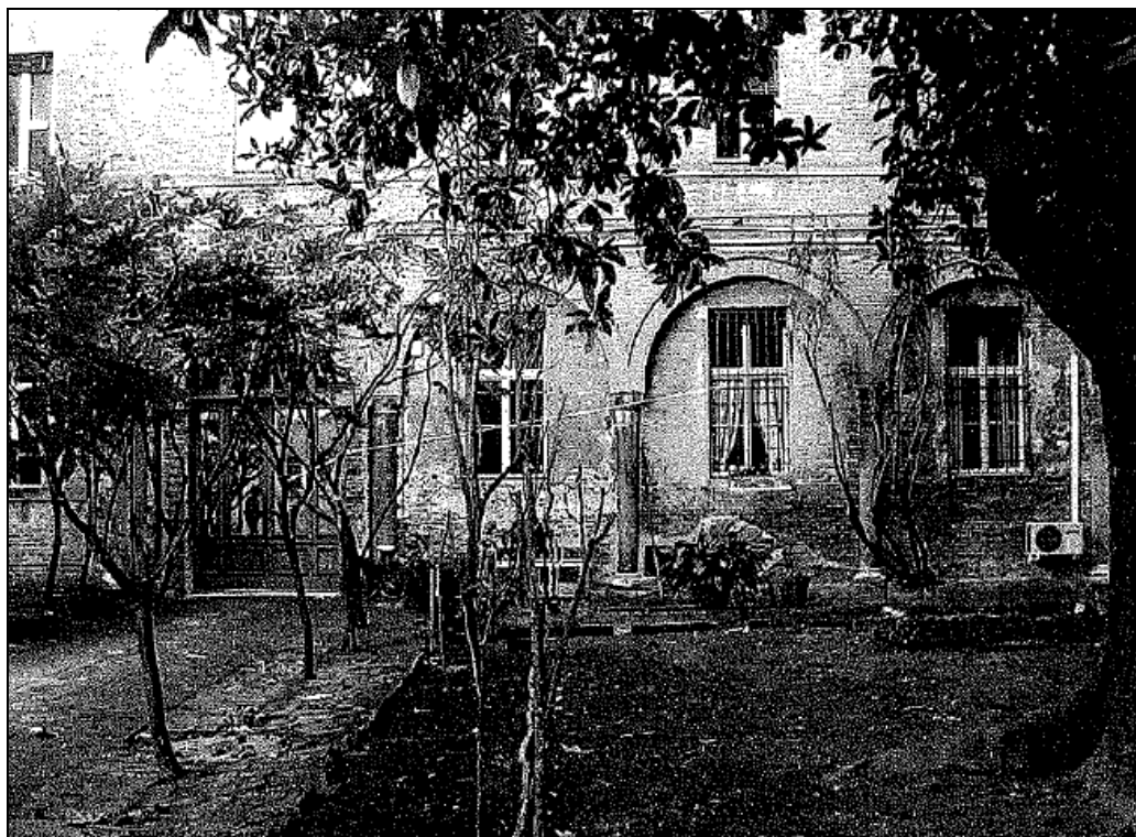
figura 3.2 - Prospetto Sud su corte interna: Palazzo Strozzi
