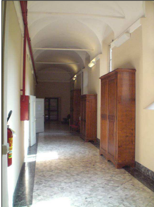
Figura 5.3.3b - Ex Palazzo Strozzi: Volte con tiranti - Foto n°89
