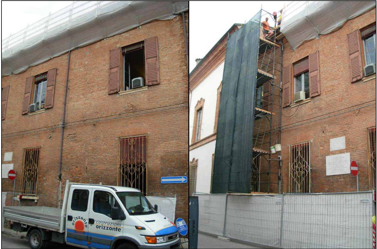
Figura 5.1.11 - Foto n°:33-34 - P.T. (Ex-Palazzo Strozzi)
