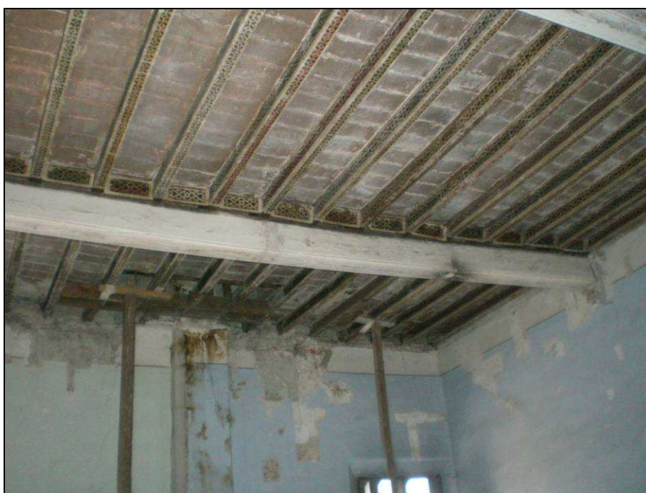
Figura 5.3.7 - Ex Casamento Savonarola: Solaio di piano secondo - locale su via Savonarola
