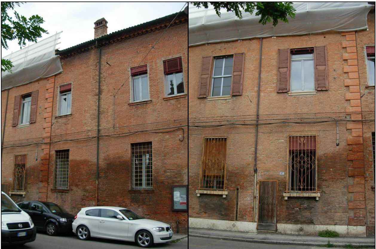
Figura 5.1.10 - Foto n°29-30 - P.T. (Ex-Casamento)
