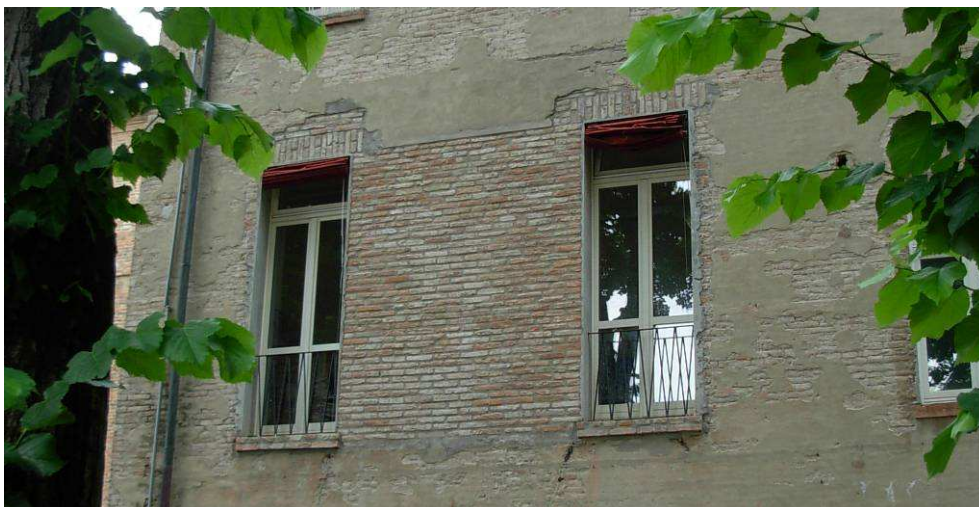
Figura 5.1.4 - Ricostruzione parete muraria (Foto n°8 - P.T.)
