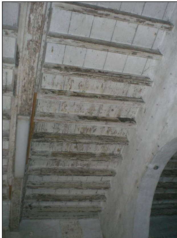
Figura 5.3.4b - Ex Palazzo Strozzi: solai lignei (a vista) - Foto n°100
