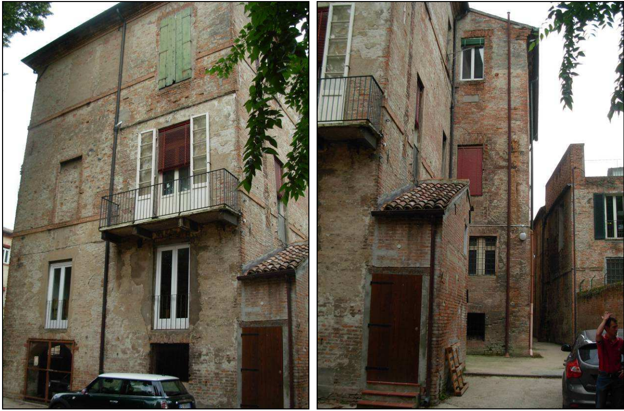
Figura 5.1.16 - Corpo Settentrionale originario dello Strozzi: Vista prospetti N-E e N-O.
