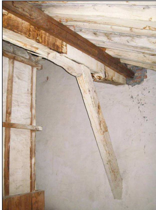
Figura 5.3.9 - Ex-Casamento Savonarola: strutture lignee di copertura (Foto n°46, 48)
