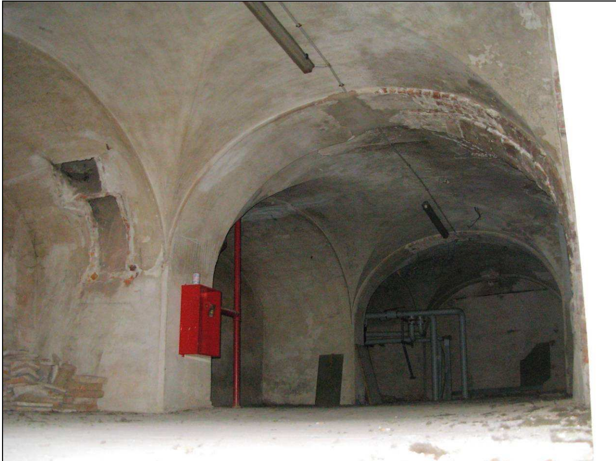
Figura 5.3.2 - Ex Palazzo Strozzi: Sistema di volte a sostegno P.T. - Corpo settentrionale Est
