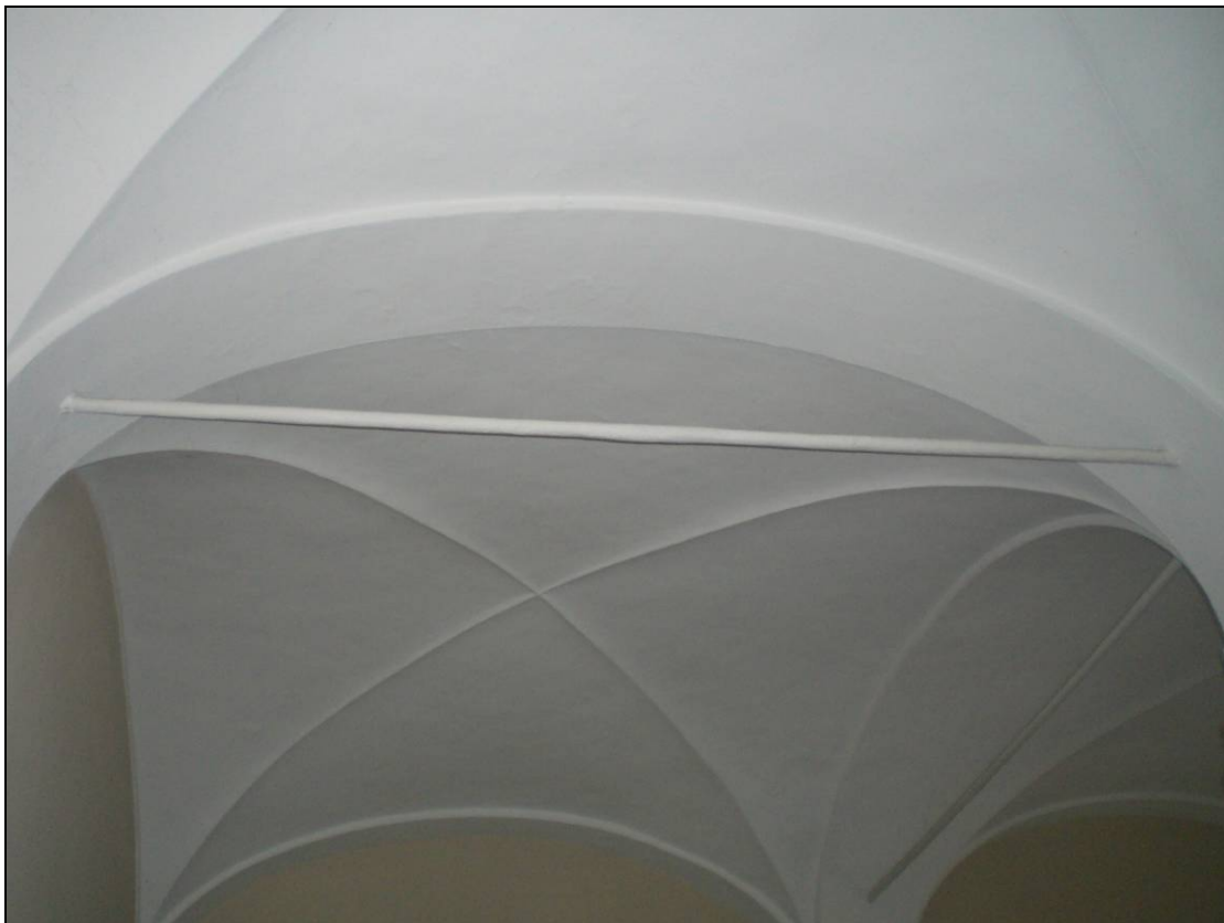
Figura 5.3.3c - Ex Palazzo Strozzi: Volte con tiranti - Foto n°:127-129
