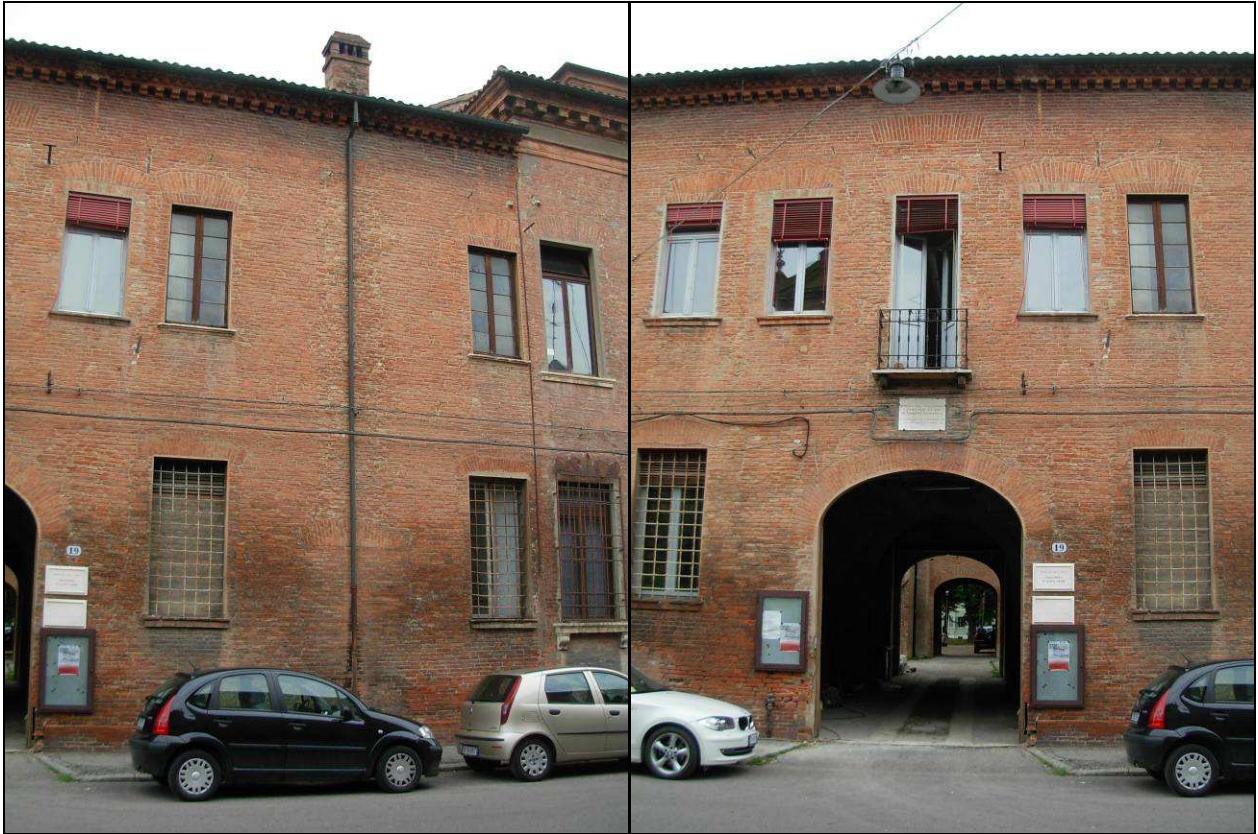
Figura 5.1.9 - Foto n°27-28 - P.T. (Ex-Casamento)
