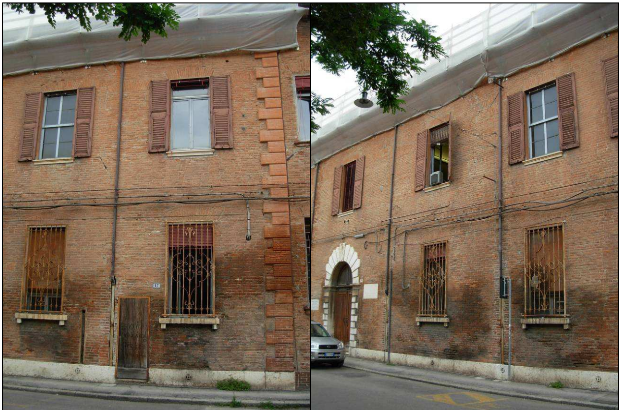
Figura 5.1.12 - Foto n°:30-31 - P.T. (Ex-Palazzo Strozzi)
