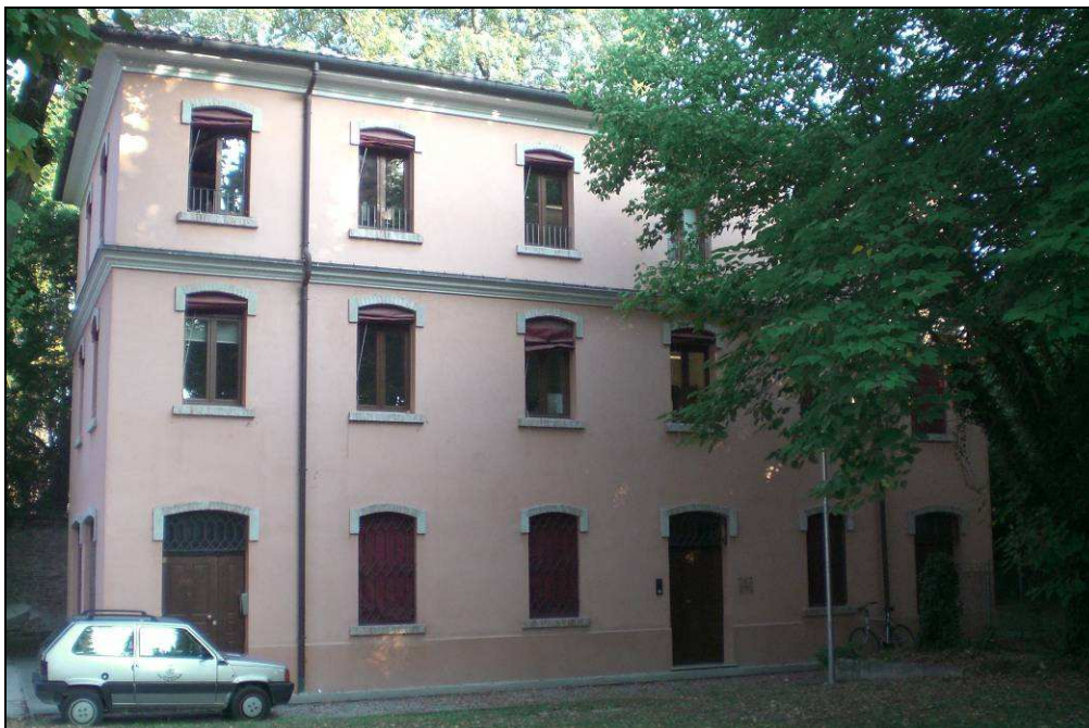
Figura 5.1.18 - Fronte principale fabbricato "Ex-lavanderie"
