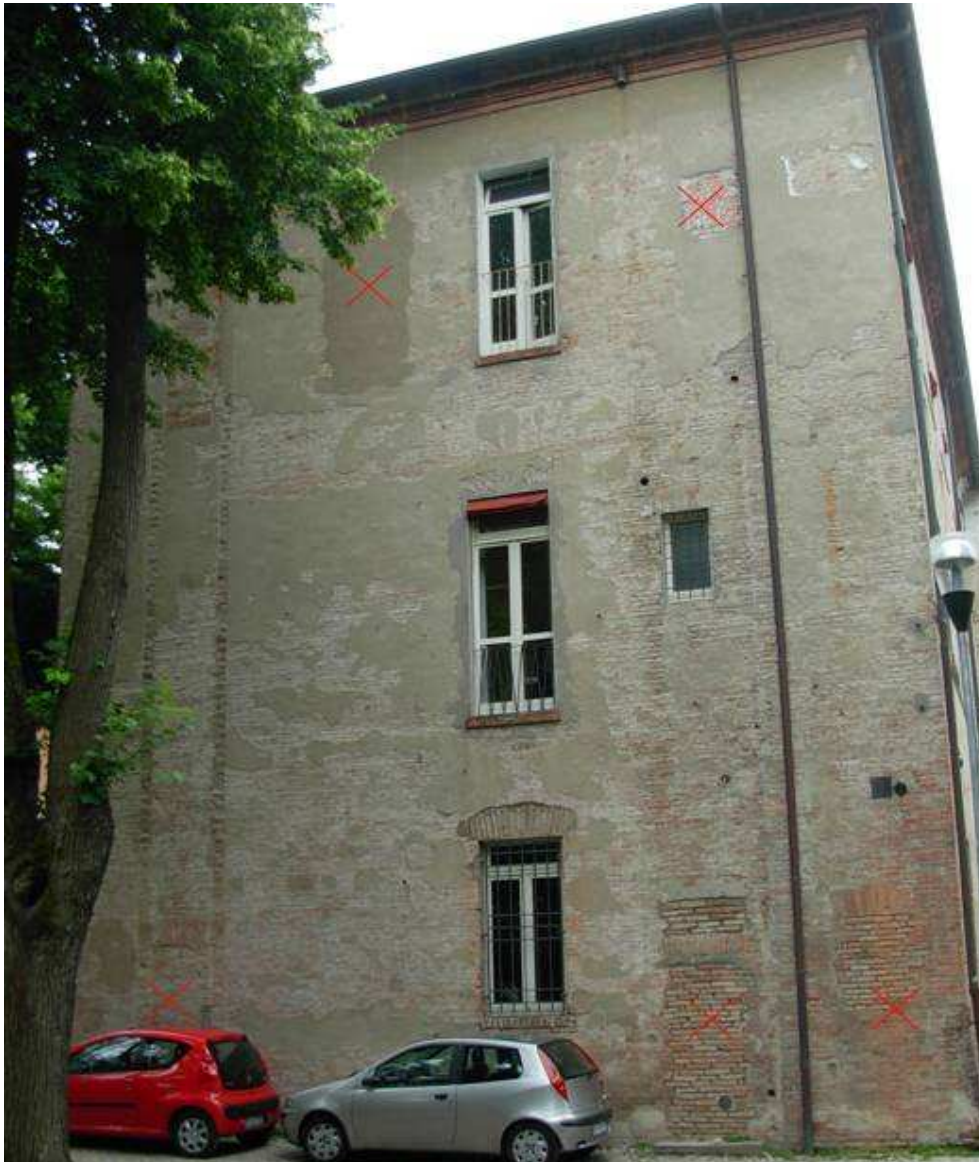
Figura 5.1.3 - Segni dell'esistenza di precedenti aperture (Foto n°5 - P.T.)
