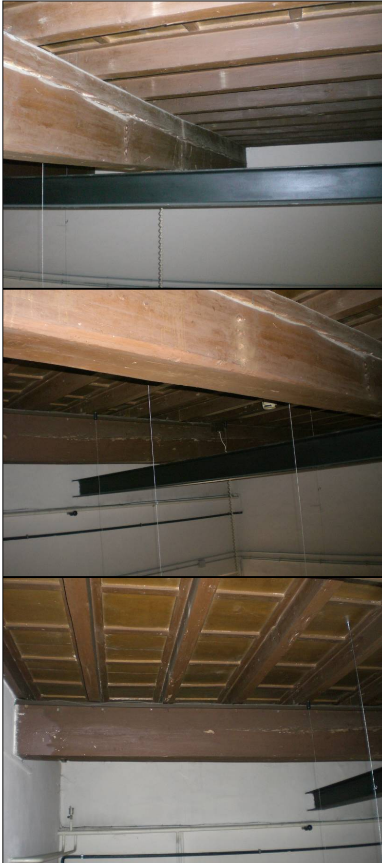
Foto n°.28a, 28b, 28c
