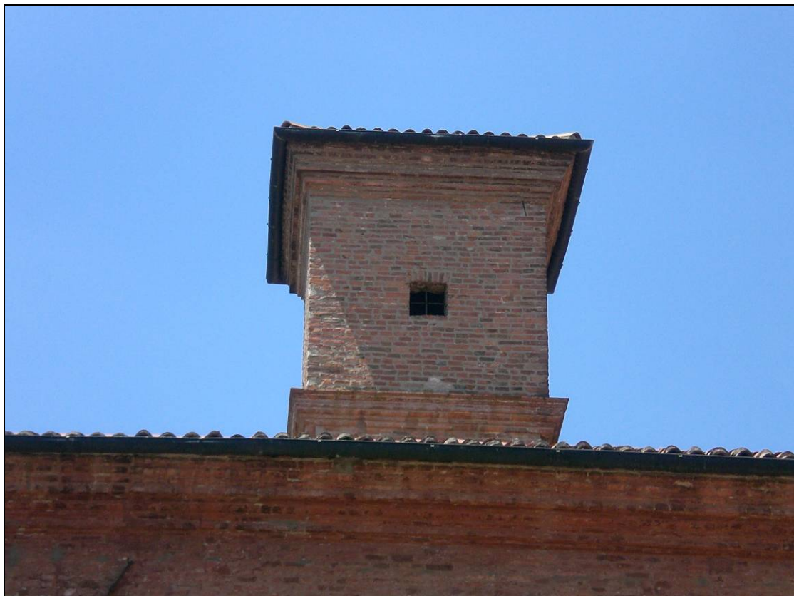
figura 2.4 - "Torretta": vista da corte interna
