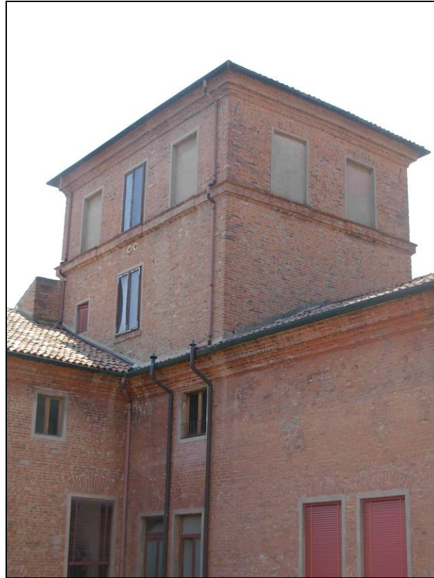
figura 2.3 - Torre: vista da corte interna
