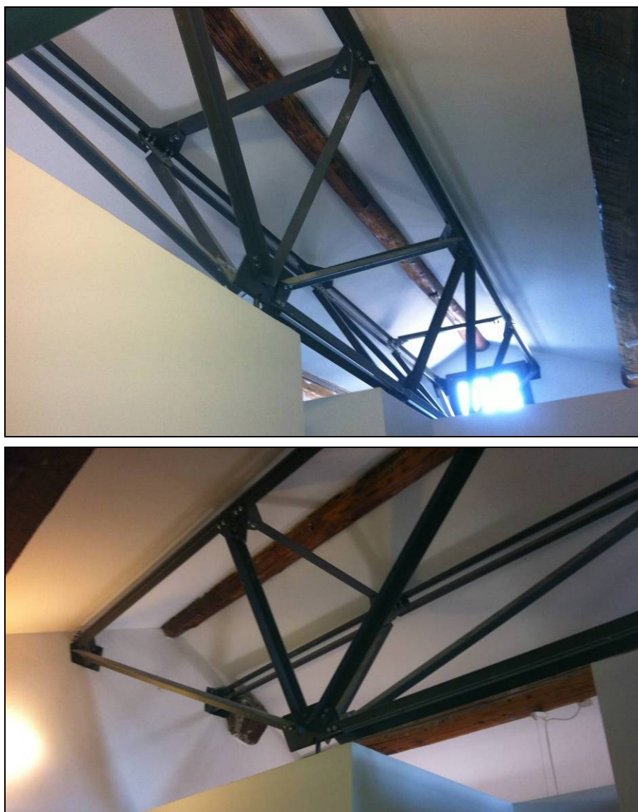
Figura 4.8 - trave reticolare in acciaio a piano secondo
