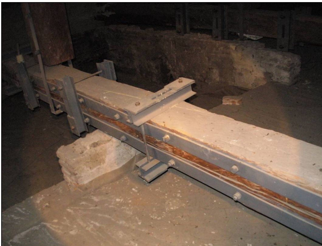
Figura 4.9 - consolidamento catene capriate
