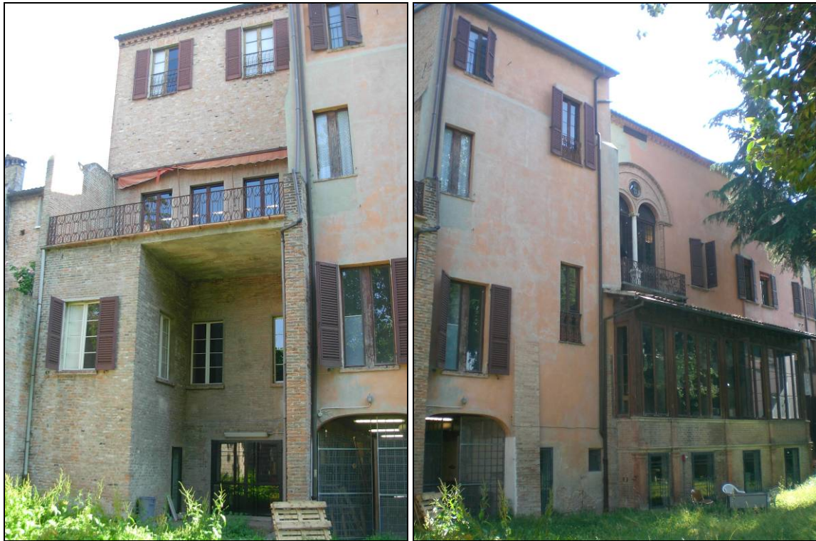
figura 2.3 - Palazzo Gulinelli: fronte posteriore
