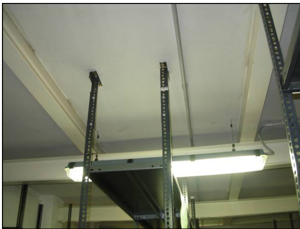
figura 4.4.1d - solaio in acciaio (A) - deposito biblioteca (foto n°. 19, 20)
