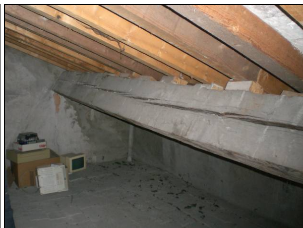
figura 4.4.4b - Solaio ligneo di copertura (foto n°.10, 11)
