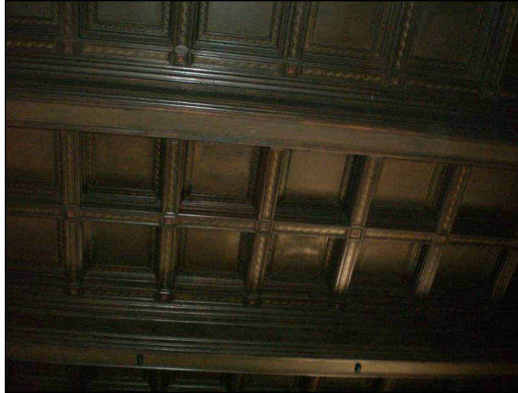
figura 4.4.3b - Solaio ligneo cassettonato (foto n°.21)
