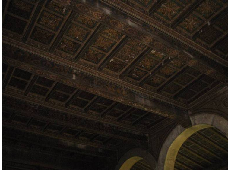
figura 4.4.2c - solai lignei - ex-salone (foto n°.10)
