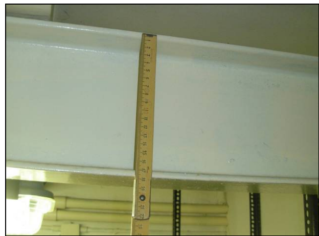
figura 4.4.1d - solaio in acciaio (A) - deposito biblioteca (foto n°. 19, 20)
