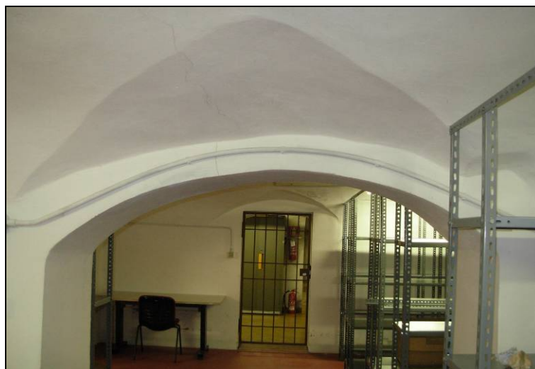
figura 4.4.1e - volte in muratura
