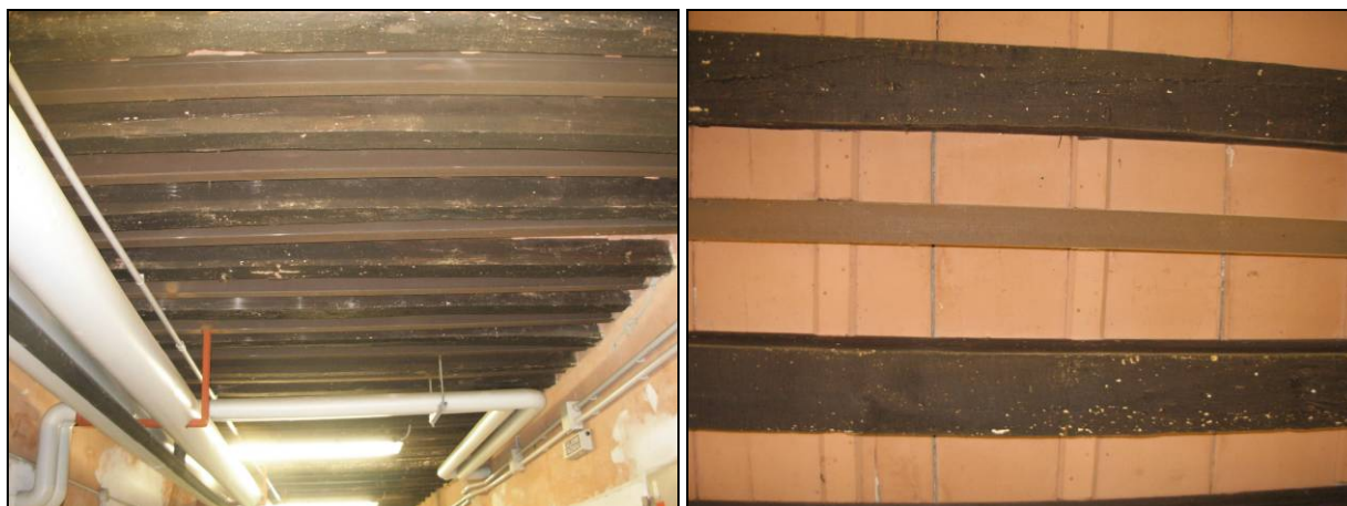
figura 4.4.1b - solai lignei zona "androne" (foto n°.3, 4)
