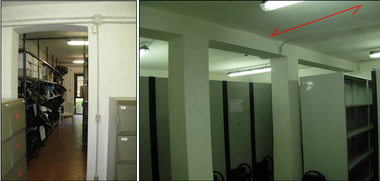
figura 4.4.1c - solai in latero-cemento (LC) - deposito biblioteca (foto n°. 17, 18)
